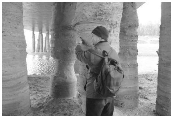
Ijstijdafzettingen (Saalien) op pilaren ecoduct. Foto: Leny Huitzing
